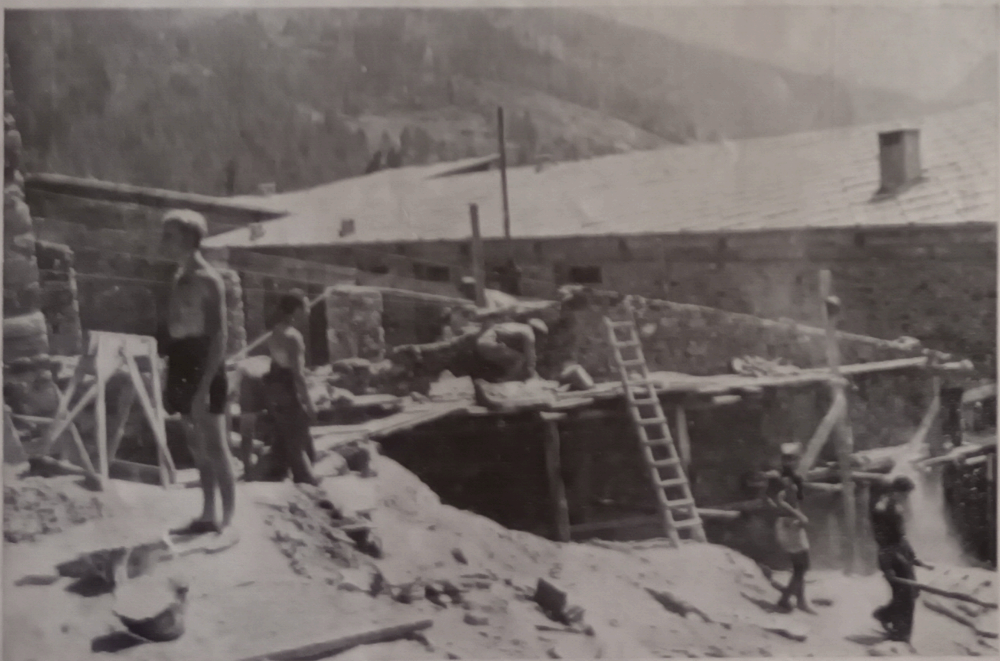
(in alto) Tre ragazze che lavorano come uomini. Sono addette al rifornimento calce. (in basso) Quando le mura di Agapé si alzano, il lavoro diviene un canto di amore!
