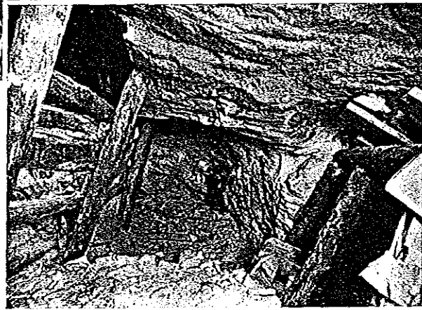
(fol. comm. Scoffone, Torino) UN CANTIERE DI SCAVO DEL TALCO NELLE MINIERE DI SAPATLÉ.
