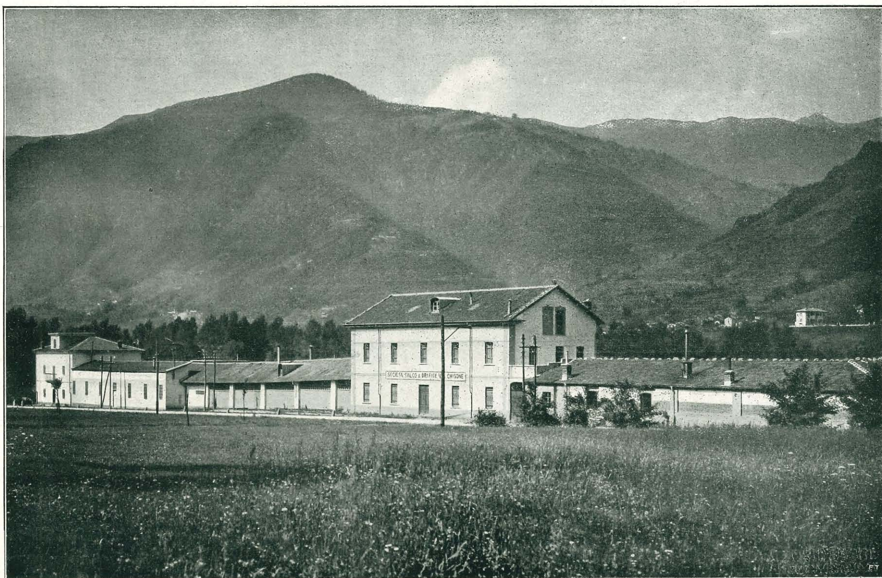
Stabilimento di Villar Perosa: Il talco trasformato in materiale isolante per elettrotermica: forse primo nucleo di applicazioni grandiose.
