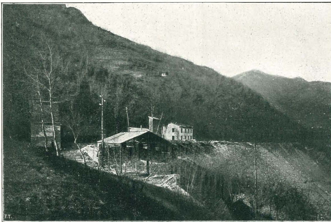
Imbocco galleria detta « Ribasso San Germano » della miniera di grafite « Icla Brutta Comba ». Sviluppo totale delle gallerie servite dal detto Ribasso: metri 12 000.
