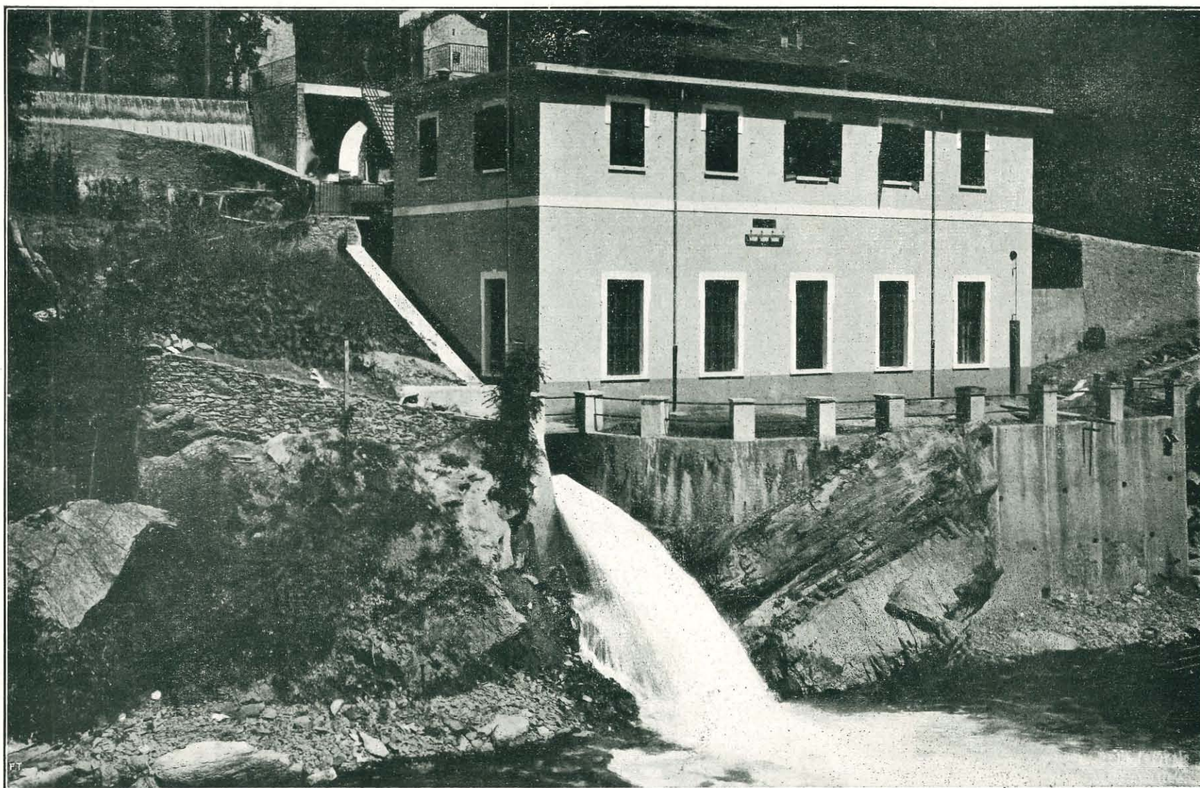
I sistemi più moderni fanno già parte del patrimonio minerario della Società: ecco le due stazioni idro-elettriche, Perretto e Riclaretto, che forniscono alle miniere, fino ai 2100 metri di altezza, la forza per agire perforatrici e martelli pneumatici, per illuminazione, ecc., ecc.
