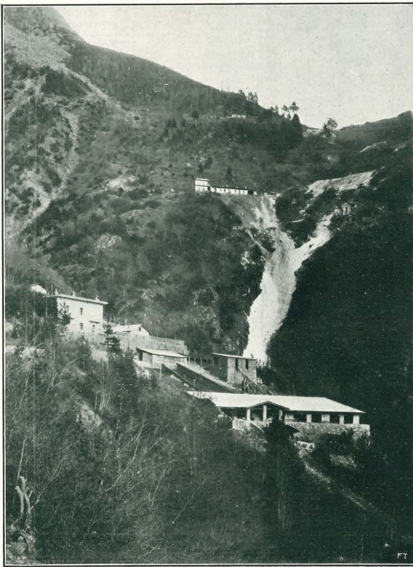
Alta Valle del Chisone: Miniera della Roussa, altitudine m. 1450. - 300 operai. Case dei sorveglianti, baraccamenti operai, stazioni teleferiche, sottostazione elettrica. Nel mezzo la grande discarica dello sterile che si estende su un dislivello di più di 300 m.
