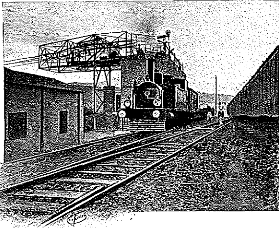
Station de déchargement dans le chemin de fer.
