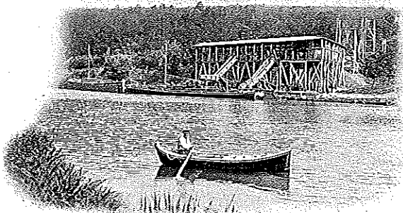
Déchargement en péniches.
