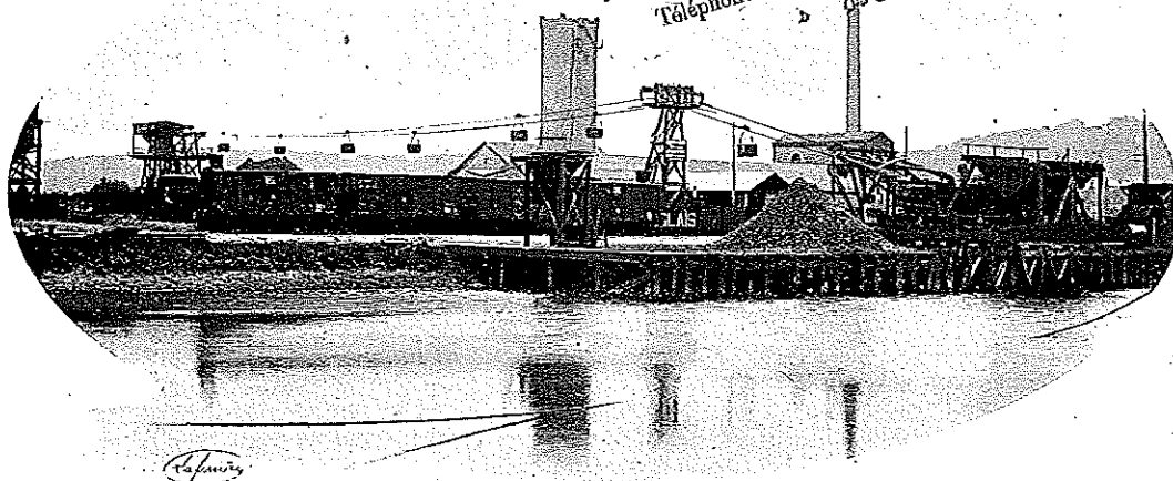
Installation bicâble dans une usine.
