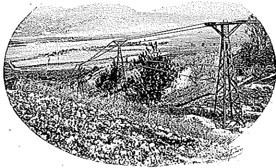
Ligne Bicâble pour transport de minerais.
